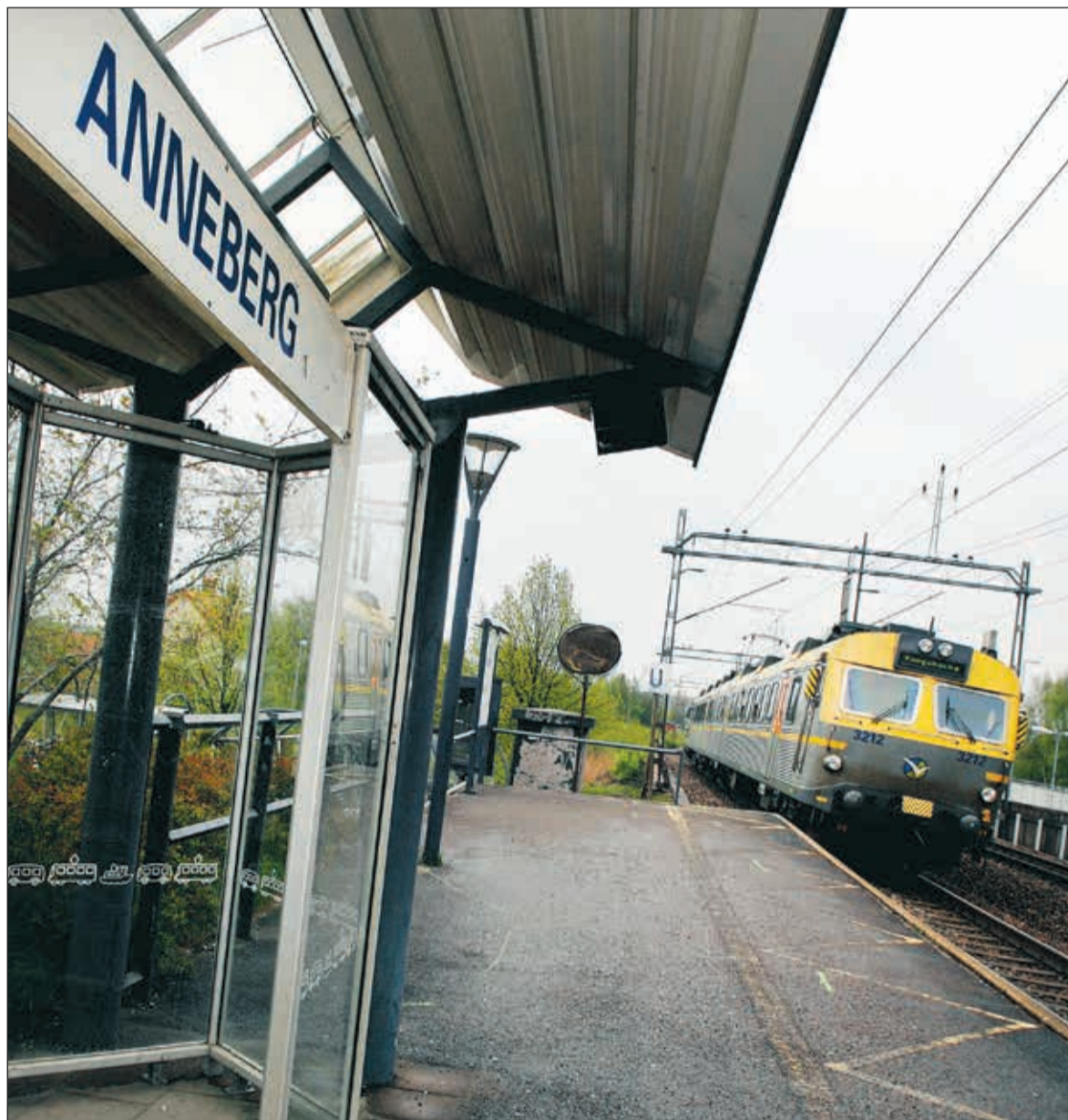
Snart under ombyggnad. Under ombyggnaden stänger Anneberg pendeltågstation från och med den 21 maj fram till den 26 augusti och Lindome station från och med den 9 juni fram till den 26 augusti. FOTO: JEANETTE LARSSON
